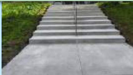
Requalificação das escadas da Rua João de Castro/Conde Aurora
