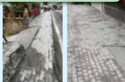
Passeios na Rua da Mouta
